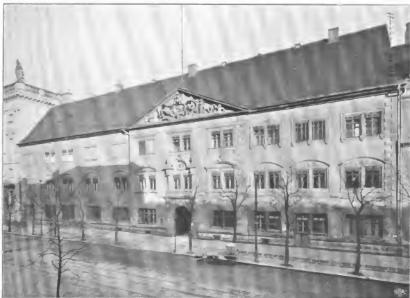
Abb. 1. Fassade des alten Marstalls in der Breitenstraße.
