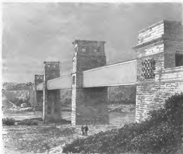
Eisenbahnbrücke über den Merseykanal (Britannia-Isola).
