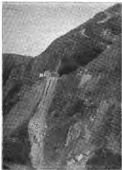
Schotterhaufen und Straße für den Marmorschlitten.
