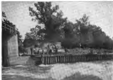
Abbildg. 1. Herstellung der Betonsenkwalze in der Form.
