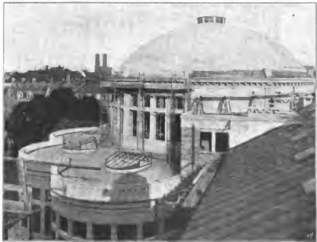
Abbildung 24. Kuppel und nördlicher Zubau nach der Ausschalung. Der Neubau der kgl. Anatomie in München.
