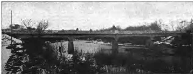
Abbildg. 22. Brücke über die Iller in Härtnagel bei Kempten.
