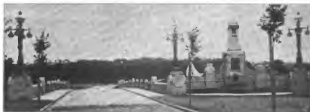
Abbildg. 10. Ludwigsbrücke in Erlangen mit Brunnenanlage. (Blick auf die Fahrbahn.)
