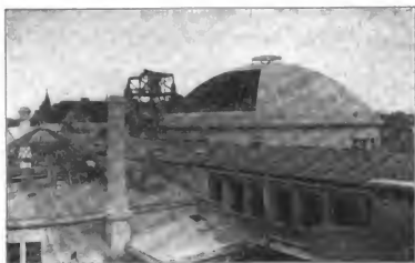
Abbildung 28. Blick auf die Hauptkuppel und das Dach des Hörsaals.
