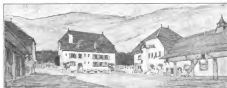
Maschinen- und Kesselhaus und Ackerbau-Kolonie.
