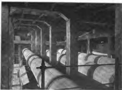
Abbildg. 13. Innenansicht der Ofenhausanlage vom 2. Brennerpodest aus. Zementfabrik für Drehofenbetrieb in Eisenbeton. Text vergl. Nr. 1.
