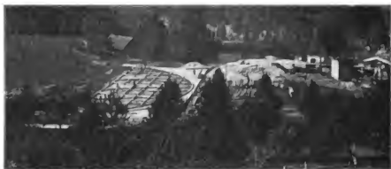
Abbildung 18. Zusammenlegung des Lehrgerüstes der Hauptöffnung vor Aufstellung.
