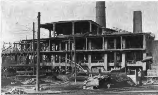
Abbild. 10. Oestlicher Mittelteil der Ofenhausanlage während der Ausführung.
