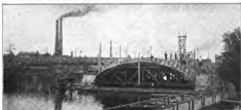
Abbildung 17. Lehrgerüst und Einschalung der massiven Seitenöffnung. (Notbrücke für Rohrleitungen.)
