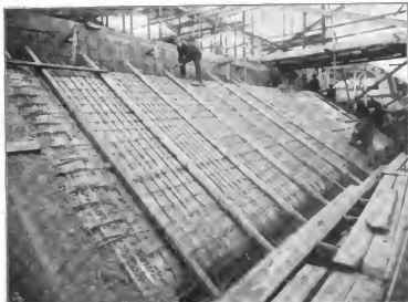
Abbildung 11. Herstellung der Eisenbetondächer der Seitenhallen.
