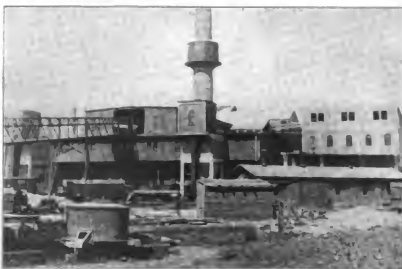
Abbildg. 3. Ansicht von Norden. Ofenhauanlage, 2 Kohlenilos, Zementsilo, Laderampe.
