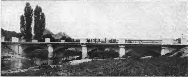
Abbildung 1. Gesamtansicht der in Eisenbeton verbreiterten Amrichen-Brücke in Eisenach.
