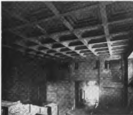
Abbildung 13. Vorhalle während der Ausführung.
