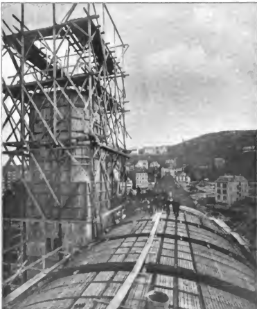
Abbild. 11. Ausführung des Eisenbeton-Gewölbes.
