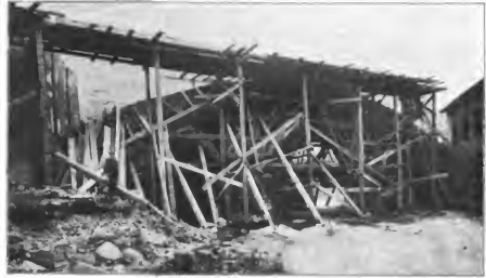
Abbildung. 10. Ausführung des Gewölbemaßwerks. Schloß der Scheitelfuge.
