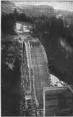
Abbildung 20. Herstellung des Hauptgewölbes. Die Ömänder Tobel-Brücke bei Teufen (Appenzell), Schweiz.
