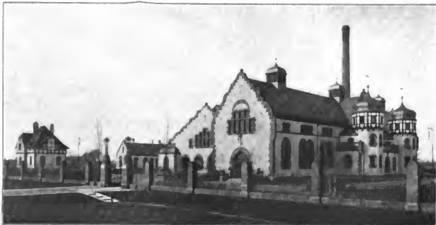
Das neue Wasserwerk Hochkirchen der Stadt Cöln. Gesamtansicht von Osten.
