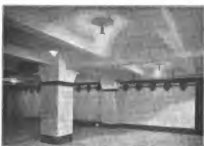
Abbildgn. 9 und 10. Blick in den Lichthof und Keller.
