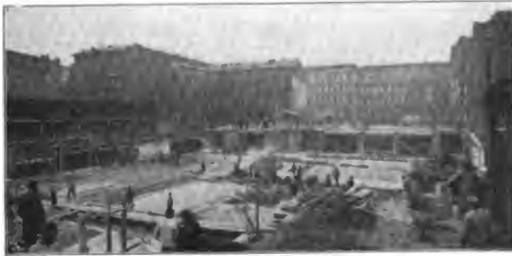
Abbildg. 1. Herstellung der Betonsohle nebst Isolierung und des Kellergeschosses der Markthalle.
