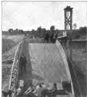
Abbildung 5. Ausführung der Gewölbe.
