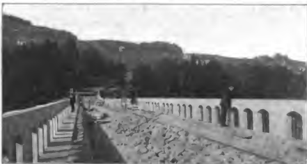
Abbildung 6. Blick auf die Fahrbahn mit fertigem Geländer. Die Gmünder Tobel-Brücke bei Trufen (Appensell), Schweiz.
