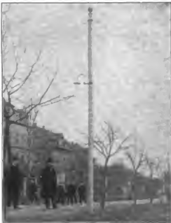
Fertiger Mast für elektrische Leitungen.
