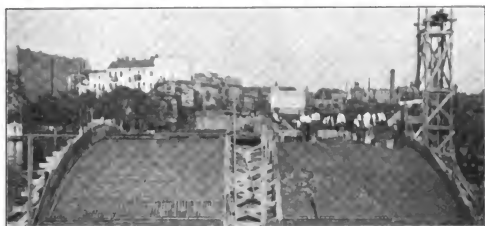
Abbildung 18. Ausführung des Eisenbeton-Gewölbes.
