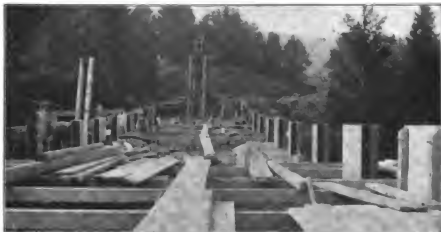
Abbildung 5. Herstellung des Geländers.
