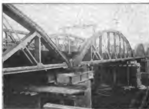
Abbildung 5. Auswechslung eines festen Auflagers.
