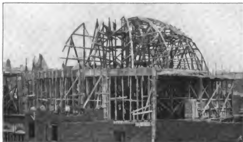
Abbildung 13. Einschalung des Kuppelringes und der Stützen. Lehrsgerüst der Kuppel.
