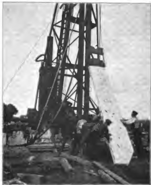
Abbildung 7. Aufziehen der Spundpläne an der Ramm- und Spülbohle.
