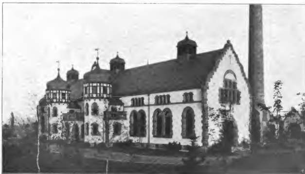
Südost-Ansicht des Maschinen- und Kesselhauses, Nordseite des Maschinenhauses. Wasserwerk der Stadt Köln a. Rh. bei Hochkrethen. Architekt: Jos. Gärtner in Köln-Müngersdorf.
