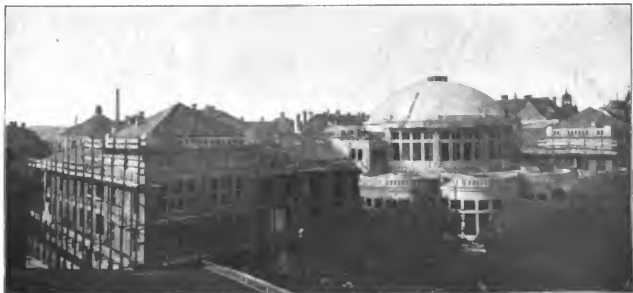
Abbildg. 19. Ansicht des Baues von der Nordseite während der Ausführung.
