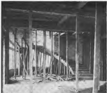
Kuppel und sonstige Eisenbeton-Konstruktionen am Neubau des Orpheum-Theaters in Bochum.
