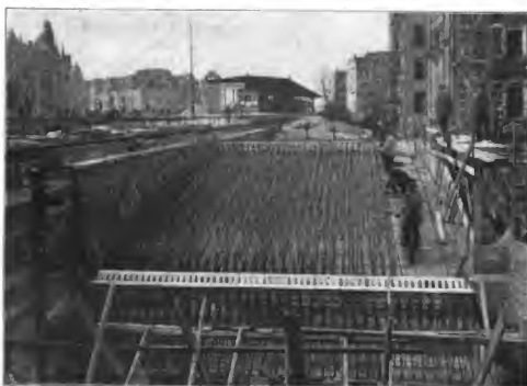
Abbildung 7. Nördliches Bauwerk. Einlegung der Eisen im Gewölbe.
