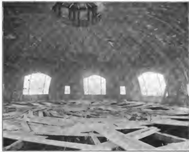
Abbildg. 28. Einblick in die Kuppel nach der Ausschalung.
