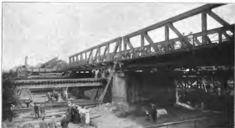
Abbildung 3. Auswechslung einer Flutöffnung. Neuer Ueberbau eingeschoben.
