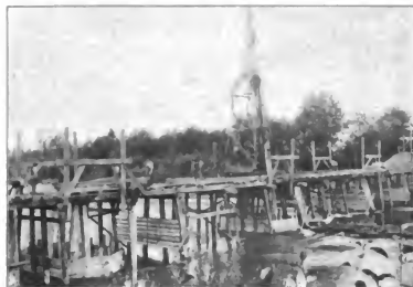
Abbildg. 20. Einrammen der Pfähle unter Benutzung der alten hölzernen Jochbrücke.
