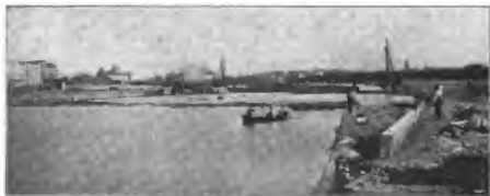
Abbildung 3. Blick in den Durchstich während der Bauarbeiten Juli 1907.
