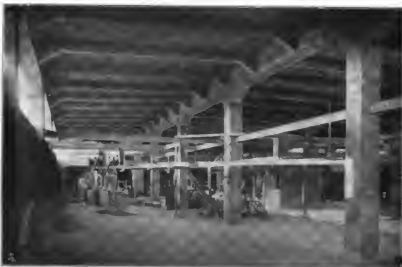
Abbildg. 12. Dachgeschloß im Mittelschiff des Ofenhauses.
