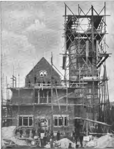
Abbildg. 10. Ausführung des Eisenbeton-Kirchturmes.
