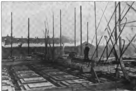
Abbildung 16. Ausführung der Kassettendecke und des Trägers über der Vorhalle.
