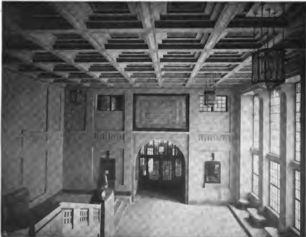
Abbildg. 2. Haupteingangshalle im Ostflügel (Kassettendecke in Eisenbeton).
