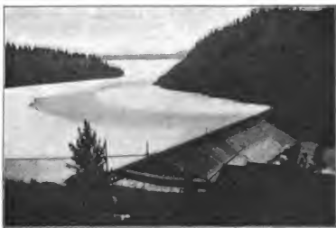
Abbildg. 2 u. 3. Staudamm vor und nach dem Einsturz.
