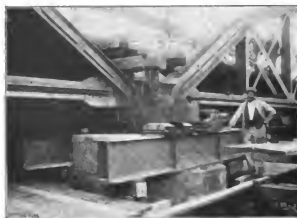
Abbildung 6. Auswechslung eines beweglichen Auflagers.
