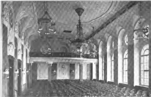
Jügelhaus in Frankfurt a. M. Aula. Architekt: Ludwig Neber, kgl. Baurat in Frankfurt a. M.
