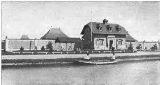
Die städtische Badeanstalt in Durlach. Ansicht des Einganges der Badeanstalt mit Verwaltungsgebäude, von der Pflanzung gesehen.
