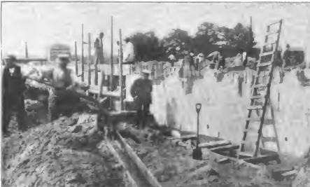
Abbildg. 11. Herstellung der Holme und Treppen der Uferschulung.
