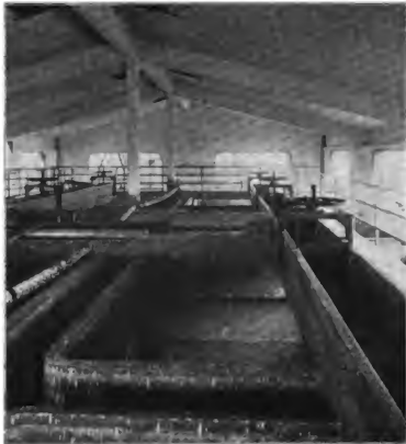
Abbildg. 7. Einblick in den Dachraum mit den Verteilungs-Latten.
