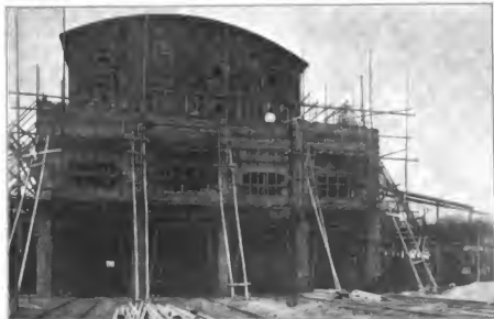
Abbildgn. 5 und 6. Kohlenturm während der Ausführung. (Dahinter die alte Kohlenwäsche.)
