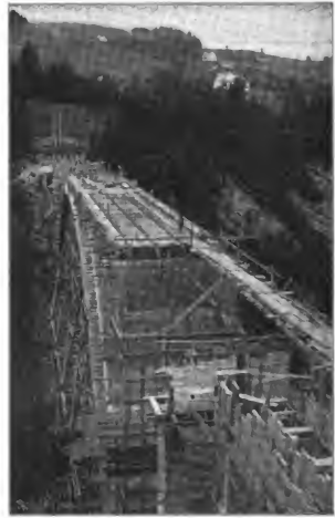
Abbildung 21. Herstellung der Säulen auf dem Hauptgewölbe (Text in No. 98.) und der Fahrbahntafel.
