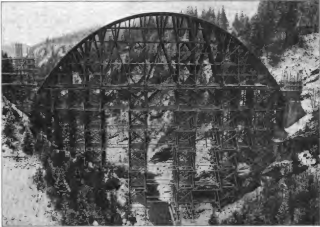
Abbildung 16. Fertig aufgestelltes Lehrgerüst der Hauptöffnung.
