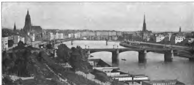
Lage der Mainbrücke in Frankfurt a. M. Photogr. Aufnahme von C. F. Fay in Frankfurt a. M. (Im Hintergrunde die alte Brücke.)
