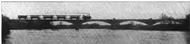
Abbildung 1. Gesamtansicht der vollendeten Eisenbahnbrücke.
