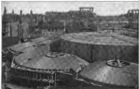
Abbildung 23. Einschalung der Kuppeln über dem Präpariersaal und des Tambours der Hauptkuppel.
