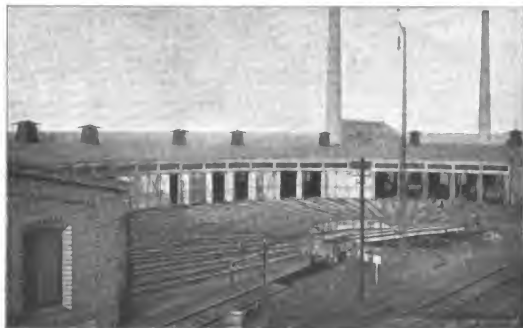
Abbildg. 2. Lokomotiv-Feizhaus auf dem Hauptbahnhof Chemnitz mit Eisenbeton-Konstruktion der Innenumfassung.
