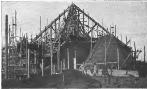
Abbildung 6. Hauptdach der Kirche während der Herstellung.
