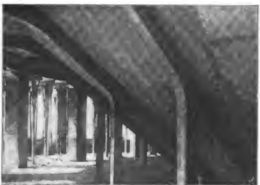
Abbildung 30. Unterbau der amphitheatralisch aufsteigenden Sitze im Hörsaal. Der Neubau der kgl. Anatomie in München.
