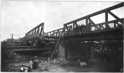
Abbildung 2. Auswechslung einer Flutöffnung. Einschleiben des neuen Ueberbaues.
