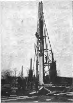
Abbildung 8. Ramm- und Spülgerüst fertig.
