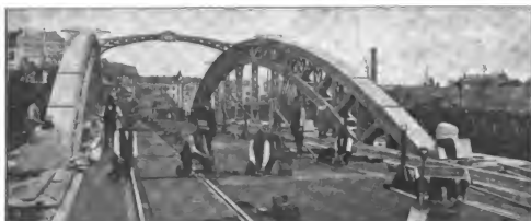
Abbildung 6. Einblick in den eisernen Ueberbau der Brücke. (Verlegung des Holzpflasters.)
