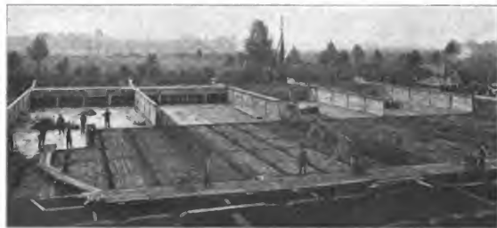
Abbildungen 8 und 9. Aufnahmen von der Ausführung des Klärbeckens.
