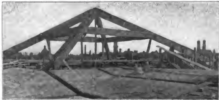
Abbildung 21. Zelt Dach über den Eckpavillons während der Ausführung.
