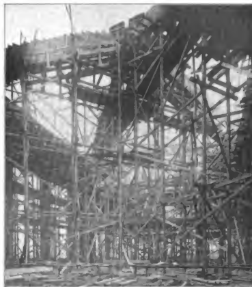
Abbildung 12. Rüstung und Schalung für die Kuppelbinder.
