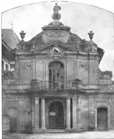
Das zum Abbruch bestimmte Historische Museum in Bern.
