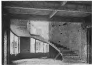
Abbildungen 25 und 26. Eingeschaltete und fertige Ehrentreppe.
