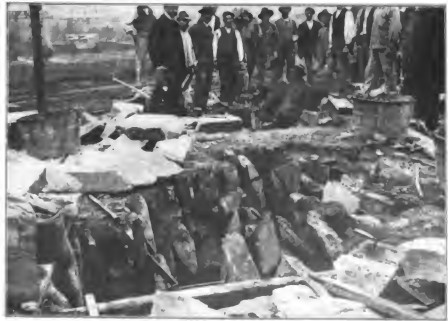
Abbildung. 10. Ausführung des Gewölbemaßwerks. Schloß der Scheitelfuge.
