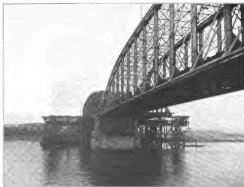
Abbildungen 18 und 19. Auswechslung der Stromöffnung im Hauptarm.
