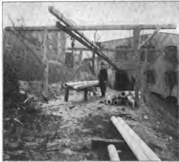
Einformung der fertigen Röhren.
