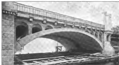
Abbildung 16. Fertiges Eisenbetongewölbe der Seitenöffnungen. (Die Gelenkstellen sind sichtbar.)
