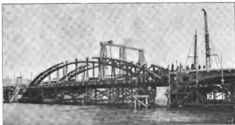
Abbildung 7. Montage der Eisenkonstruktion der Mittelöffnung.
