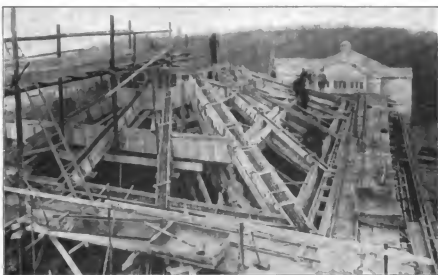
Abbildung 10. Ausführung des Kuppel-Gespärres.
