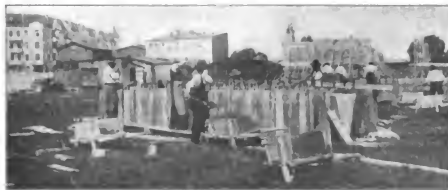
Abbildung 5. Herstellung der Eisenbeton-Spundbohlen in den Formkästen. Herstellung einer Uferschälung aus Eisenbeton beim städtischen Hafen in Spandau.
