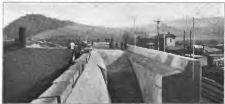
Abbildung 4. Aufsicht auf den Gewölberücken.
