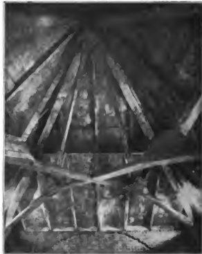
Abbildung 7. Blick von unten in das fertige Dach.
