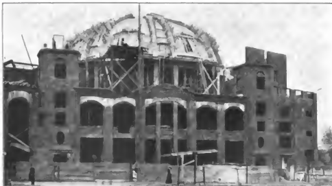
Abbildung 14. Seitenfassade im Robbau. Kuppel eingeschal.
