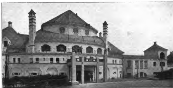
Ansicht des Hauptrestaurants von der Ganhofer-Strasse aus.
