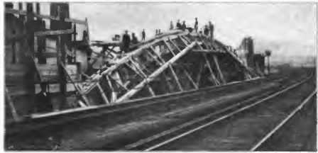
Abb. 11 u. 12. Lehrgerüst, gesehen von Fußaufwärts u. -abwärts, und Verschalung der Gewölbestr..
