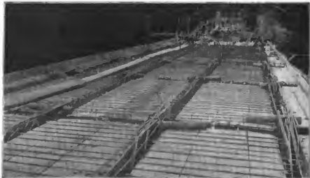
Abbildung 10. Ausführung der Fahrbanstele.
