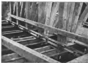
Abbildung 18. Zusammenlegung des Lehrgerüstes der Hauptöffnung vor Aufstellung.
