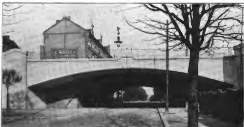
Abbildung 3. Ansicht des fertigen Bauwerkes von Söden.
