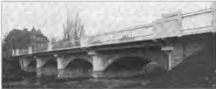
Abbildung 2. Die verbreiterte Amrichen-Brücke in Eisenach.
