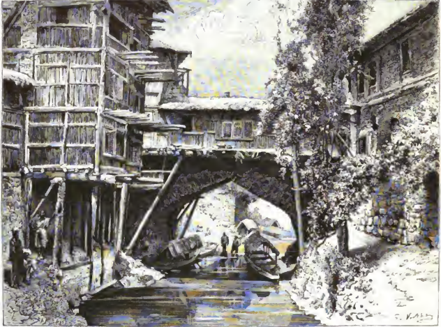
Brücke über einen Kanal in Sinagar. (Nach einer Photographie.)
