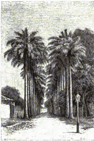
Die Straße São José in Pará. (Nach einer Photographie.)
