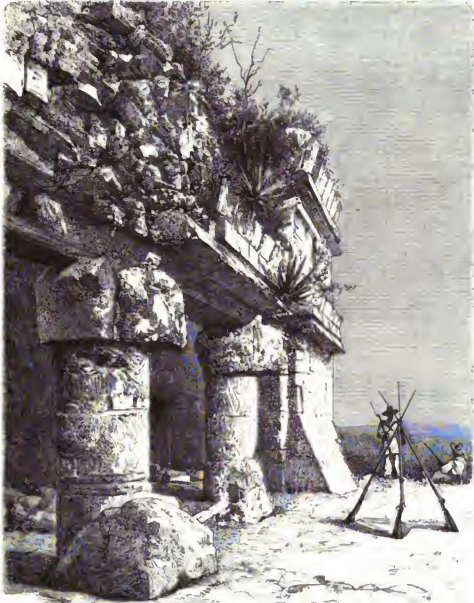
Facade des Castillo.
