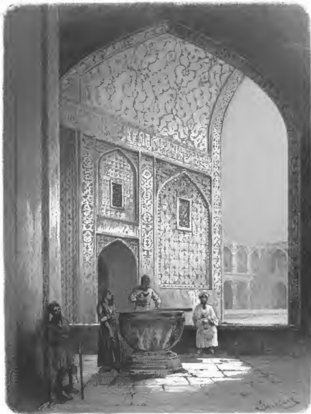
Vorhalle der Medschid-i Schah.
