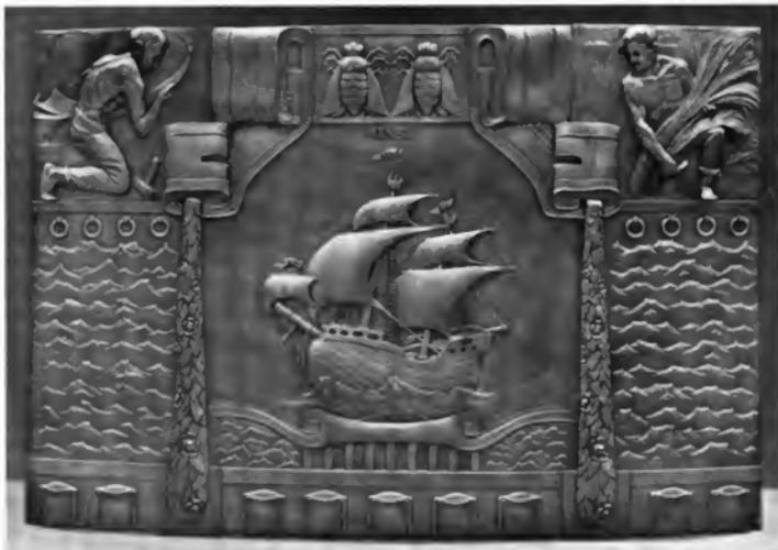
FASSADENBRÜSTUNG FÜR DEN NEUBAU DER DEUTSCHEN NATIONALBANK IN BREMERHAVEN • NACH DEM ENTWURF VON J. ALLERS IN KUPFER GETRIEBEN VON HASIS & HAHN, STUTTGART
