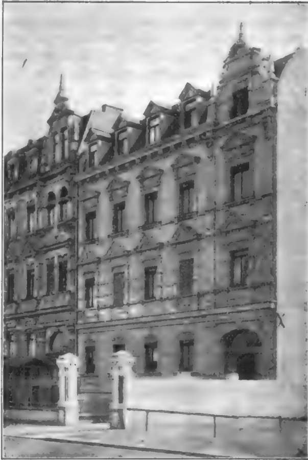
Bild 34. Haus aus Kalksandsteinen.
