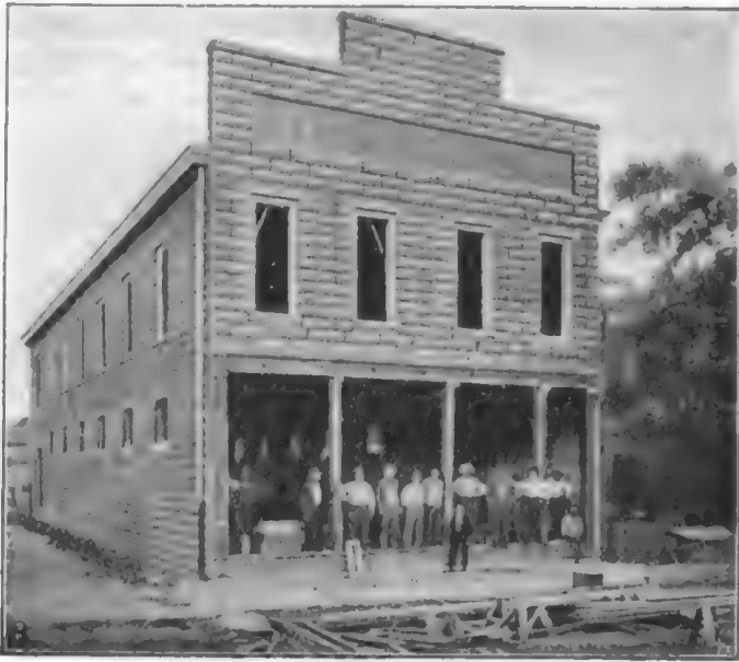
Bild 37. Haus aus hohlen Betonquadern.
