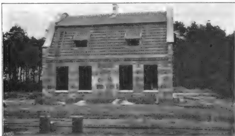
Bild 39. Fertiger Rohbau aus Zementsteinen.
