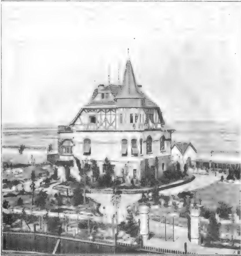
Bild 32. Haus aus Kalksandsteinen.
