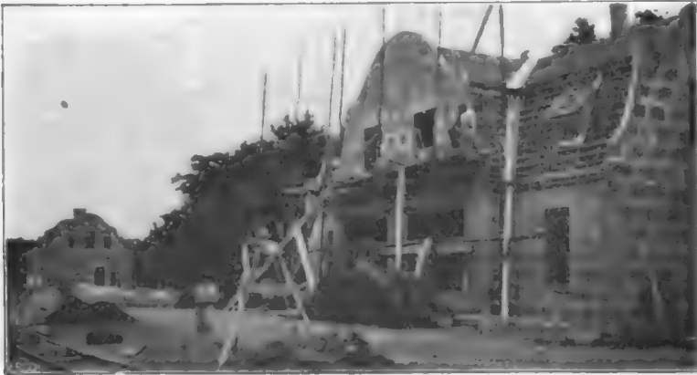
Bild 40. Landhaus aus Zementsteinen während des Baues.
