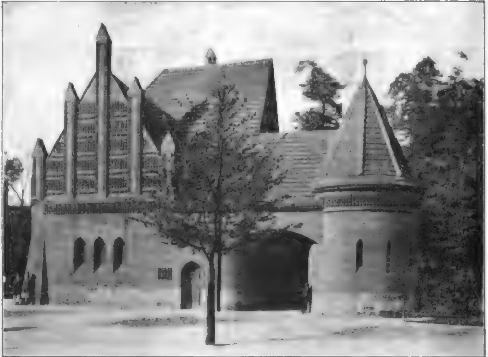
Bild 24. Straßeneinleitungsdepot am Köllnischen Park in Berlin.
