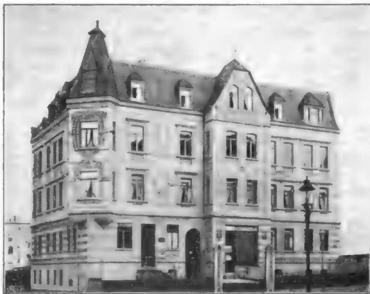
Bild 33. Haus aus Kalksandsteinen.
