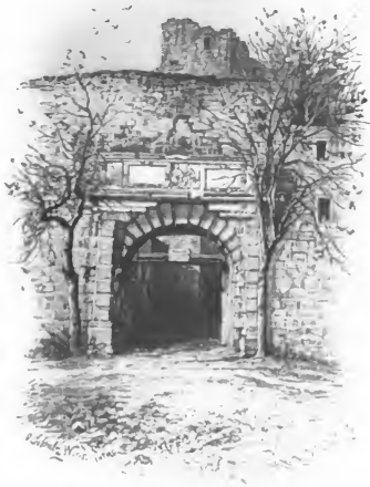
Eingang zur Ruine Hohbarr bei Zabern.
