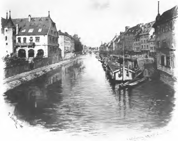
Partie an der Ill, bei der alten Metz in Strassburg.
