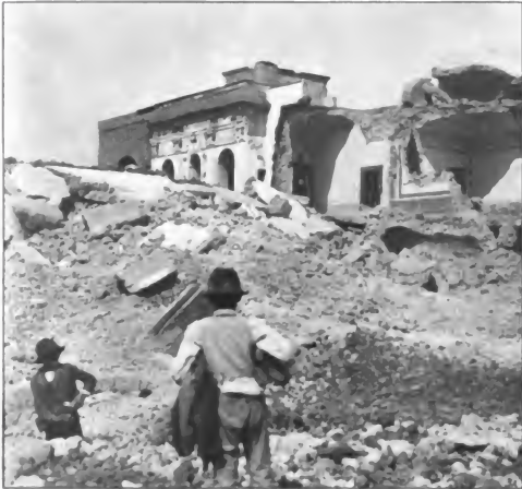
Ein von einem Lavaström eingedrückter Palast bei Bosco Crecase. Aufnahme des Verfassers.
