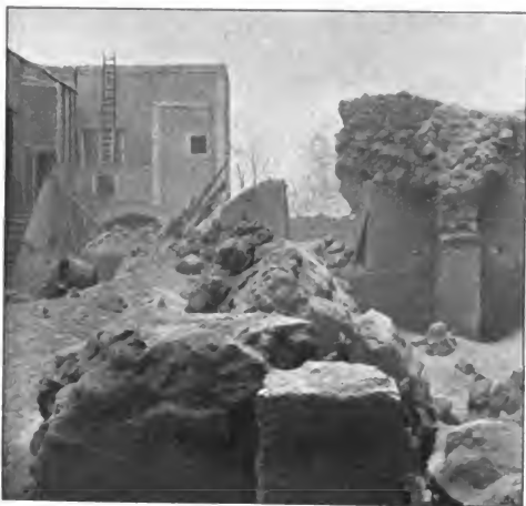
Durch den Druck der Asche zertrümmertes Haus in Ottajano. Aufnahme des Verfassers.
