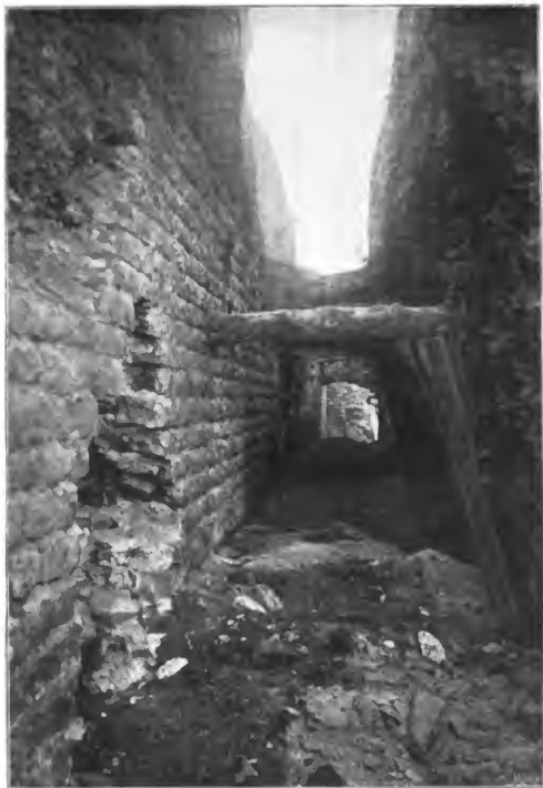
Südliche Flügelmauer des Osteingangs von Aussen.
