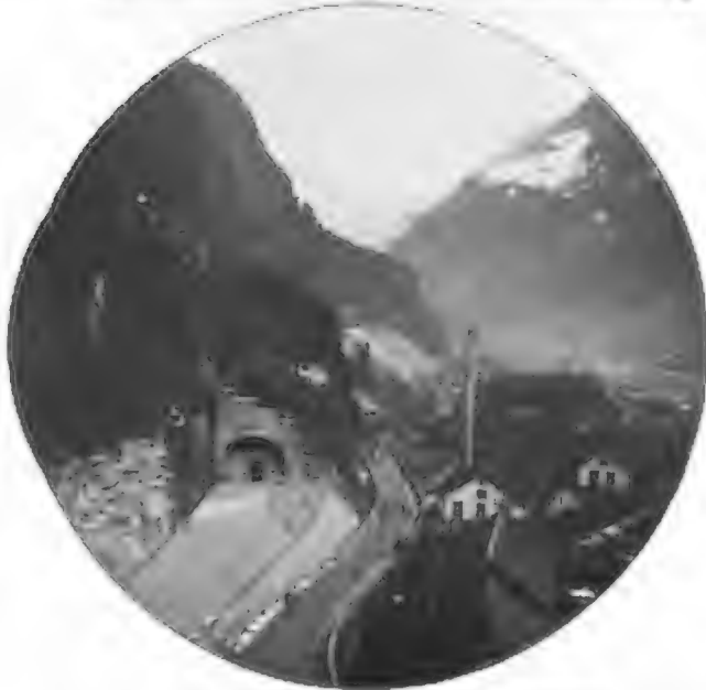
Stationen Blick vom Südeingang des Tunnels auf die Bahn
