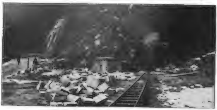
Blick vom Südeingang des Tunnels auf die Schweiz
