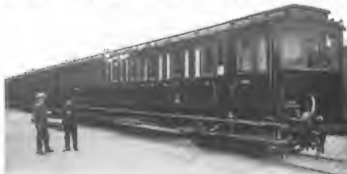
Elektrischer Zug der Staatsbahn Berlin-Zehlendorf
