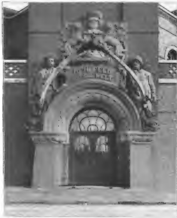
Hauptportal des Verwaltungsgebäudes der Hamburg-Amerika-Linie in Cuxhaven
