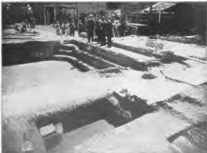
Ausgrabung des großen römischen Bades am Kranplatz in Wiesbaden
