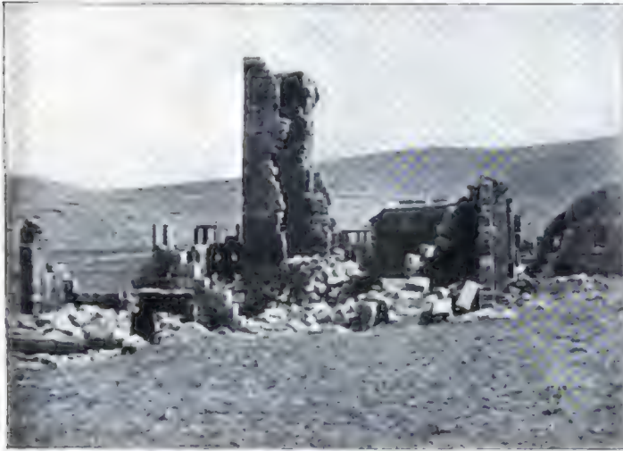
Haer-el-Benac (Wähehensbloss). Ruinen eines Sonnenhauses zwischen Klippo und Hirtelöden
