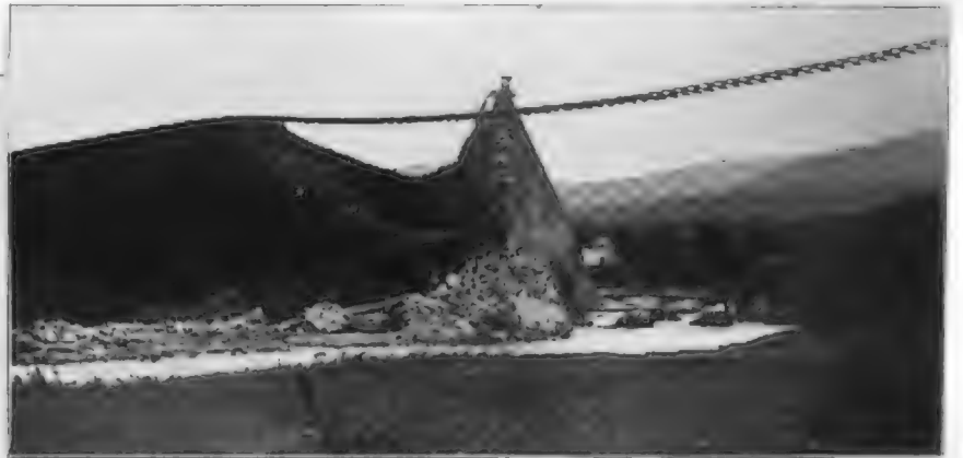
Dammbruch und eingestürzte Eisenbahnbrücke des Strichs Zwenhof-Kimmerdorf
