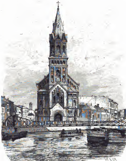
Die neue deutsch-reformirte Kirche in Peterburg.
