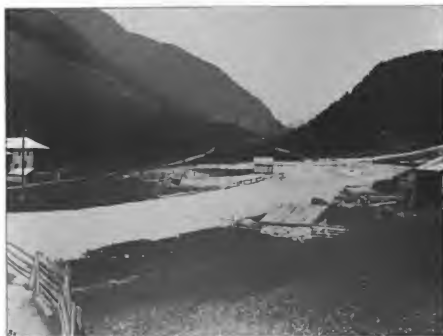
Abb. 5. Blick von der Brücke über die Trisanna bei Tschafain thalabwärts. Im Hinter- grunde, wo die beiderseitigen Hänge sich verschneiden, beginnt die Schlucht zwischen Tschafain und Mathon, rechts davor sieht man den Fuß des Muhrenkegels, in der Mitte die aufgeschotterten Flächen mit dem in viele Arme gesplinten Bach und den Vorrichtungen zur Abwehr des Hauptarmes von dem links thalab führenden Weg.
