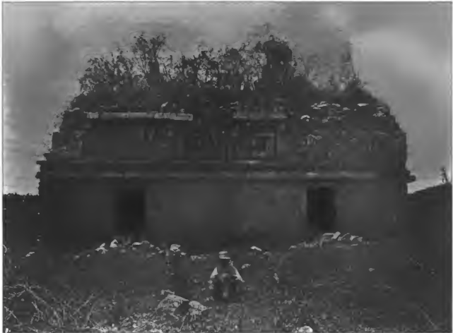
Abb. 18. Xkalupóroch. Der Malandratáinela-Palast. Südfassade.
