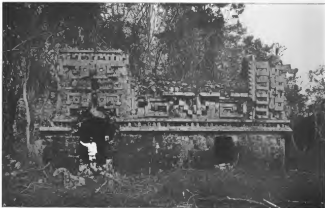
Abb. 6. Maler-Xlabpak. Die Südfassade des Hauptpalastes.
