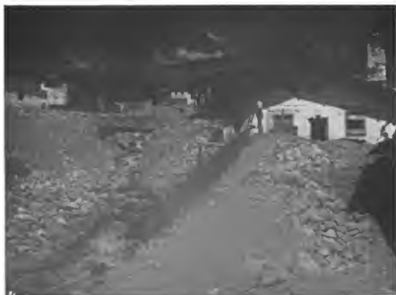
Abb. 2. Valleribachmure bei Nauders im mittleren Teile des Ortes. Stelle, an der die stärksten Beschädigungen an den Häusern stattfanden. Das Haus rechts war im unteren Stock ganz mit Murenenschutt erfüllt, der gerade daraus entfernt wird. Die Schuttkegel im Vordergrund stammen zum Teil daher. In der Mitte der Valleribach. Originalaufnahme von Dr. G. Greim.
