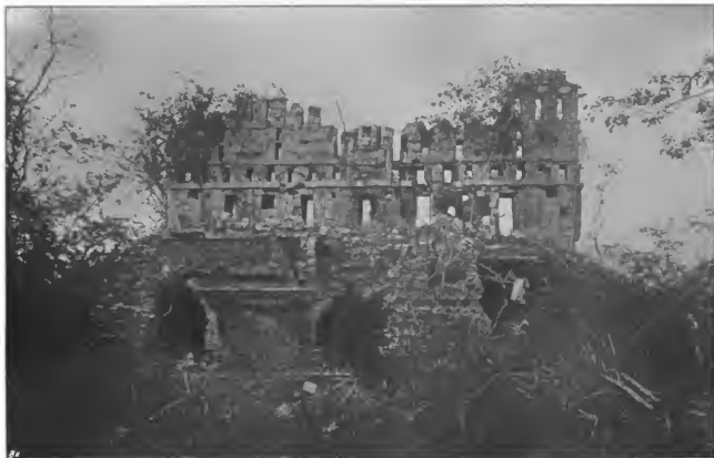
Abb. 21. Dsehkabuton. Der Bau der sechs Gemächer. Südfassade.
