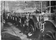
Fig. 5. Ausschnitt des Portland-Zementwerks Hünfeld.
