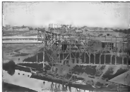
Fig. 1. Klinkerfabrik der Portland-Zementwerke Kalkbrennstoff am Kanal.
