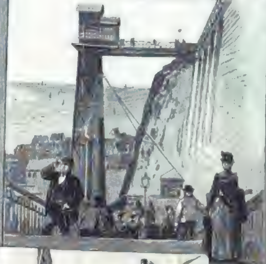
Treppe & Fahrstuhl, Verbindung zwischen Ober- u. Unterland.
