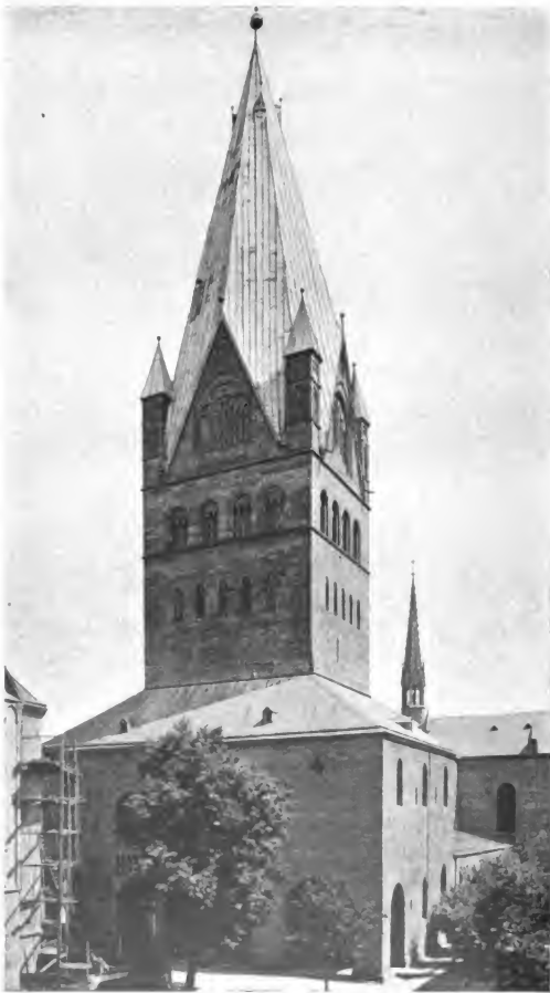
Abb. 48. St. Patroclusdom. Turm und Vorhalle. (Meßbildanstalt.)
