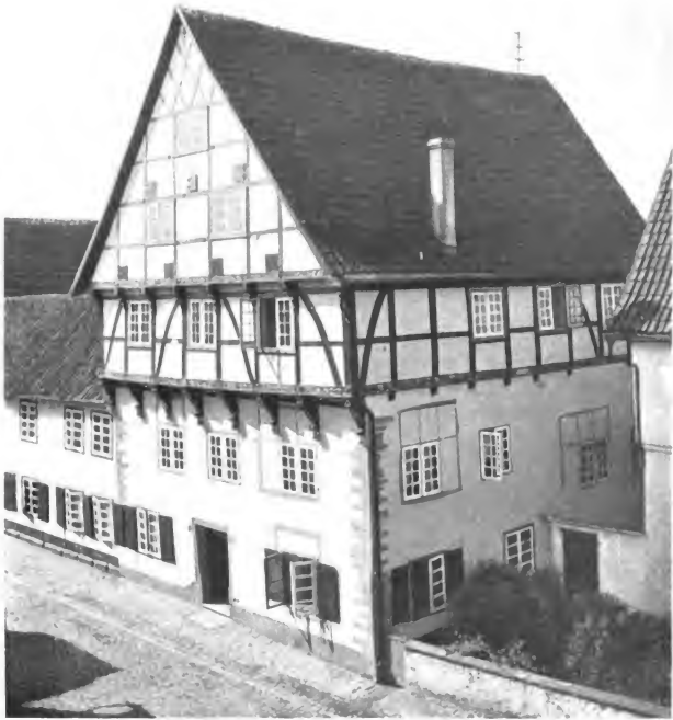
Abb. 66. Haus Grandweg 38, erbaut 1569. (Althaus.)
