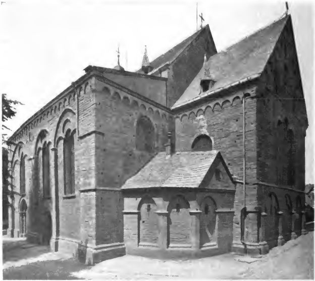
Abb. 41. Maria zur Höhe. Chor und Südwand. Anfang 13. Jahrh. (Meßbildanstalt.)
