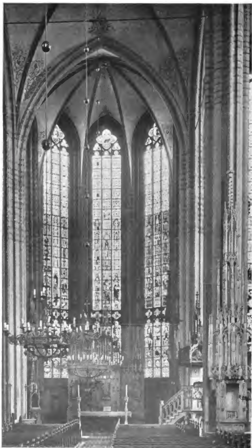
Abb. 56. Wiesenkirche, erbaut 1314–76. Blick auf den Chor. (Meßbildanstalt.)
