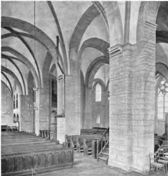
Abb. 38. St. Thomas. Blick von Osten in das südliche Schiff. (Meßbildanstalt.)
