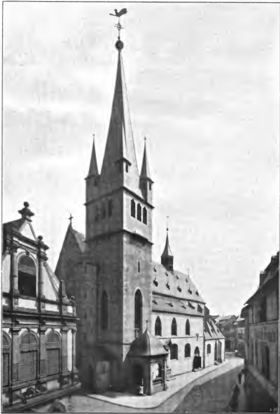
KREUZNACH. SÜDWESTANSICHT DER ST. NIKOLAUSKIRCHE.
