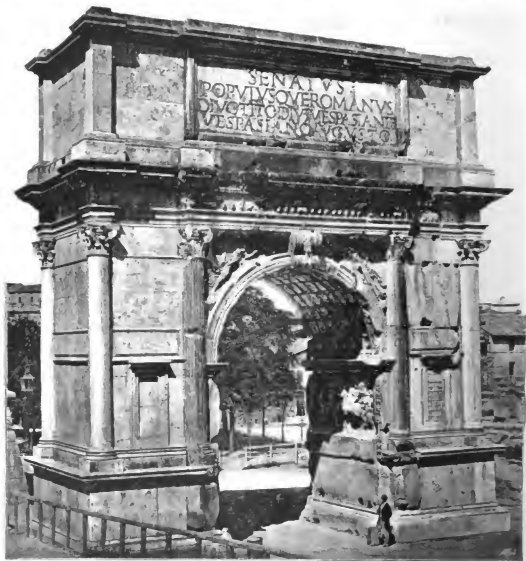
Fig. 315. Togen des Titus, Rom. Die vier Ecken sind modern ergänzt.
