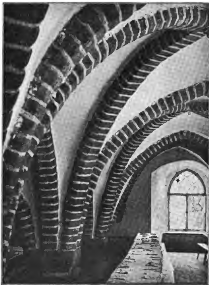
Abb. 116. Ansicht vom Erdgeschoße der Burg.
