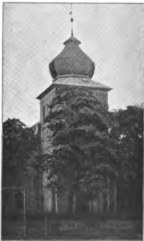
Abb. 157. Kirchturm in Reimerswalde.
