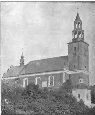
Abb. 91. Ansicht der Wallfahrtskirche in Glottau.
