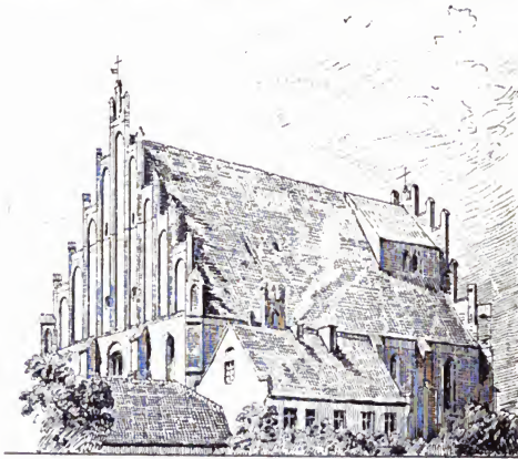
Abb. 175. Ansicht der Pfarrkirche in Seeburg.
