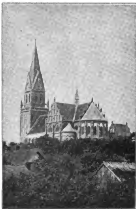
Abb. 61. Ansicht der Pfarrkirche zu Pilschwalde.
