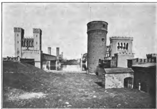
Der Buttermilchturm und die Rogatbrücken in Marienburg.
