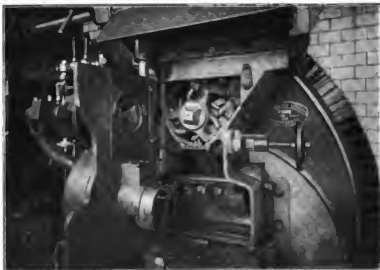
Fig. 55. Axer-Feuerung bei geöffnetem Deckel.
