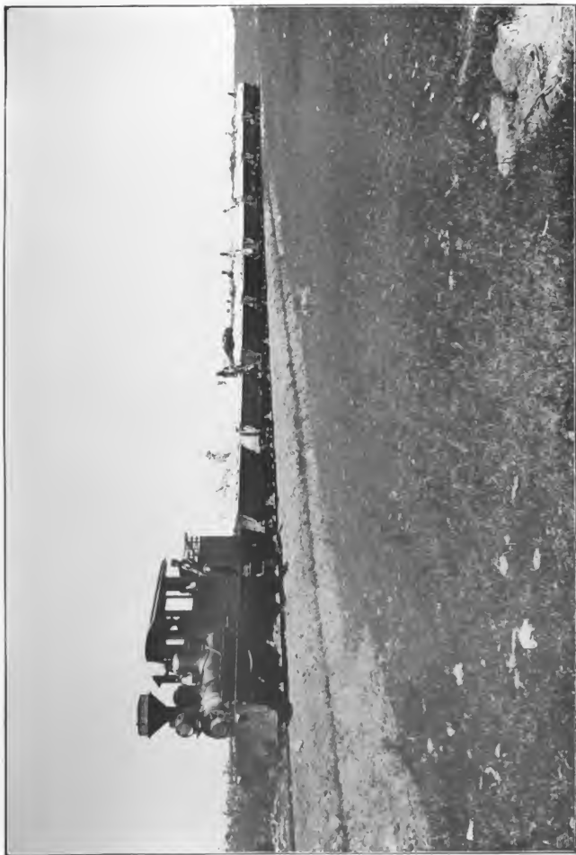
Steintransport durch eine Feldbahn mit Lokomotivbetrieb geliefert von der Aktiengesellschaft für Feld- und Kleinbahnen-Bedarf vormals Orenstein & Koppel-Berlin.
