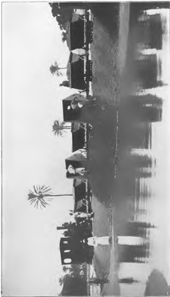
Feldbahn zum Erdtransport geliefert von der Aktiengesellschaft für Feld- und Kleinbahnen-Bedarf vormals Orenstein & Koppel, Berlin.
