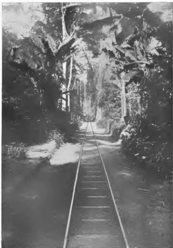
Förderbahn zum Goldtransport im Urwalde. Anlage der Arthur Koppel A. G.
