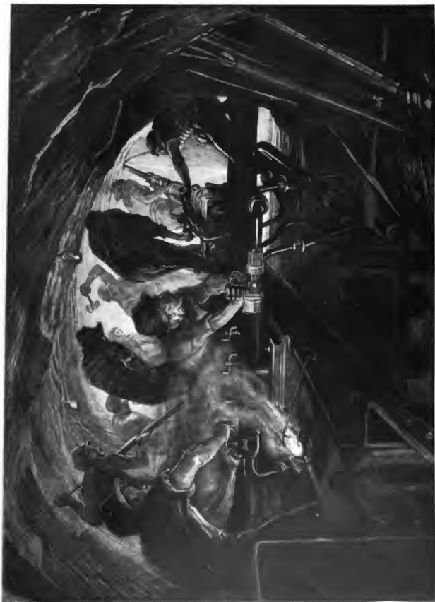
BOHRUNG IM TAURNTUNNEL (RADIERUNG)
