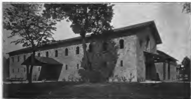
Die große Halle, prætorium , von Südosten.
