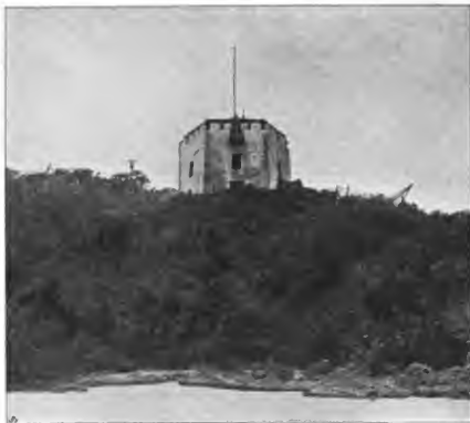
Der Wachturm auf Ras Muhesa (Pangani).
