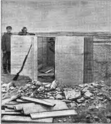
Beim Bau des magnetischen Variationshauses. Gjøhavn 1903
