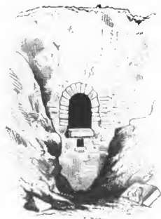
Fig. 49. Canalöffnung unter dem Nordwestpalaste von Nimrud
