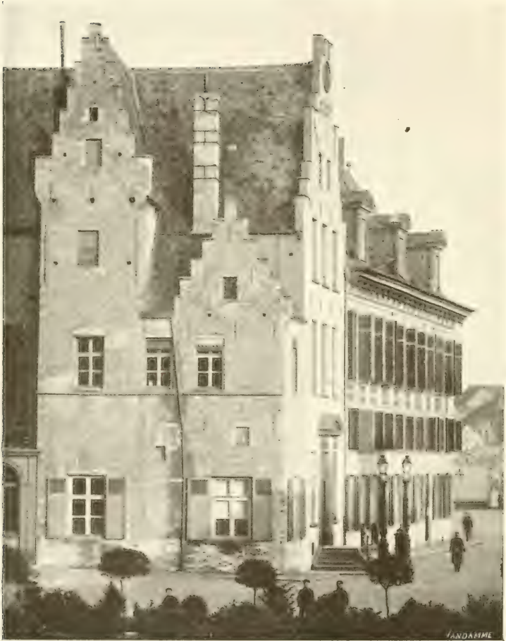
Façade vers la Métropole
