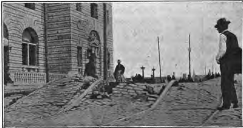
Fig. 1. — Effet du tremblement de terre sur la chaussée devant l'Hôtel des Postes de San Francisco.
