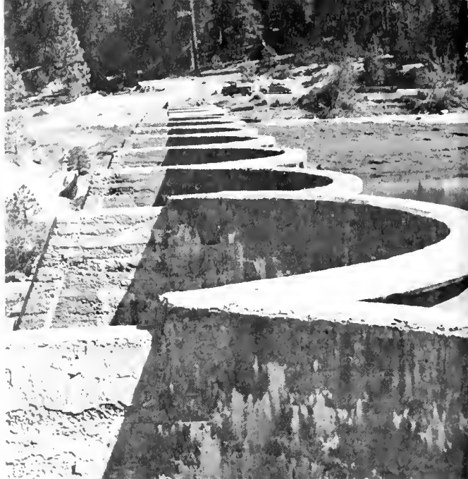
Hume Lake Dam.
