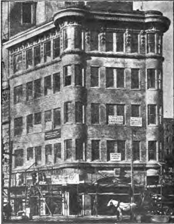
Flannery Building, San Franciscos första byggnad af reenforced concrete efter branden 1906. Uppförd af J. V. Stanquist.
