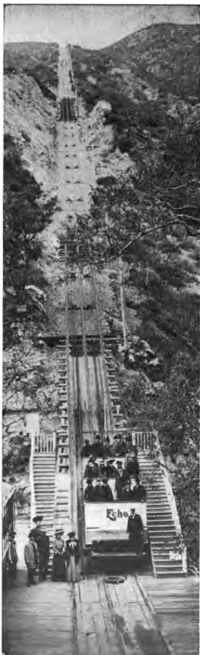
Kabelbanan på Mount Lowe.
