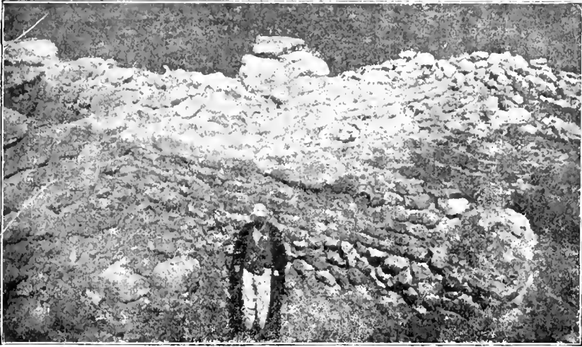
Fig. 12. — Mésopot. Construction en briques sur un soubassement de pierres. D'après Sautman, MuNDPT. , 1907, p. 71.
