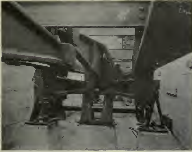
FIG. 3—CENTRAL TRANSVERSE LEVERS OF 150 TON
