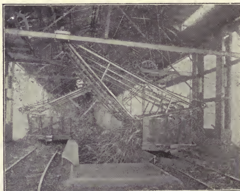
DESCARGADORA "GREGG" PARA CARROS DE CAÑA.
