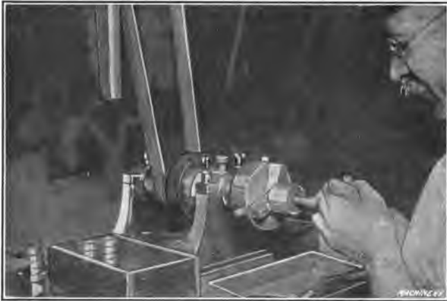
Fig. 5. Lapping a Redrawing Die
