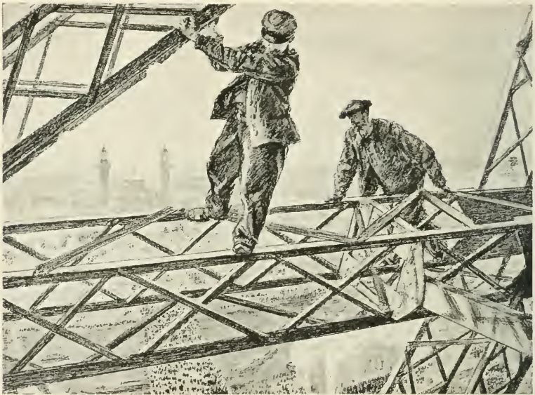
Les Electriciens posant des lampes dans la Tour Eiffel.— Posing electric lamps in the Eiffel Tower.
