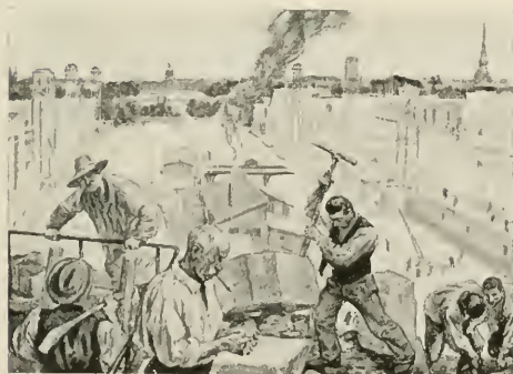
Construction des deux Palais. — Constructing the two Palaces.
