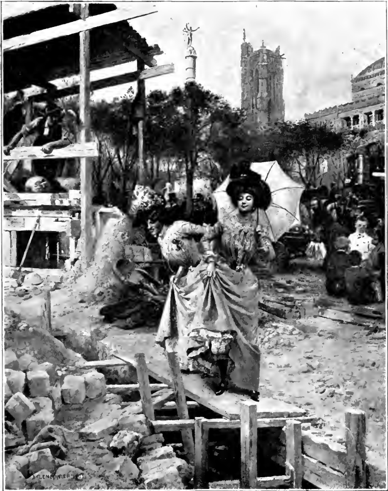
LEMEUNIER (B.), Travaux du Métropolitain, à Paris. Constructing the Metropolitan (Paris).
