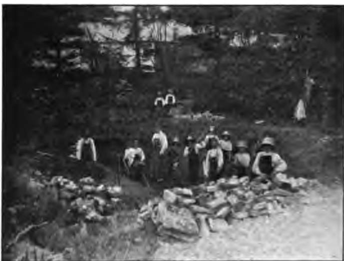
Creusement de la piscine par les élèves de Cempuis.
