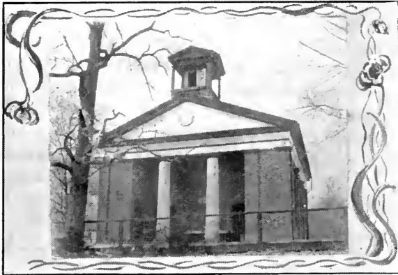
TIMBER RIDGE, VA.
