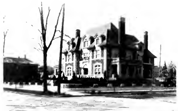
RESIDENCE OF L. M. FLESH, PIQUA
