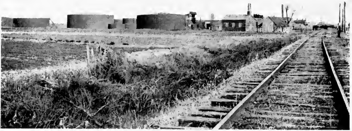
FIG. 95.—LOUISIANA. STORAGE TANKS.
