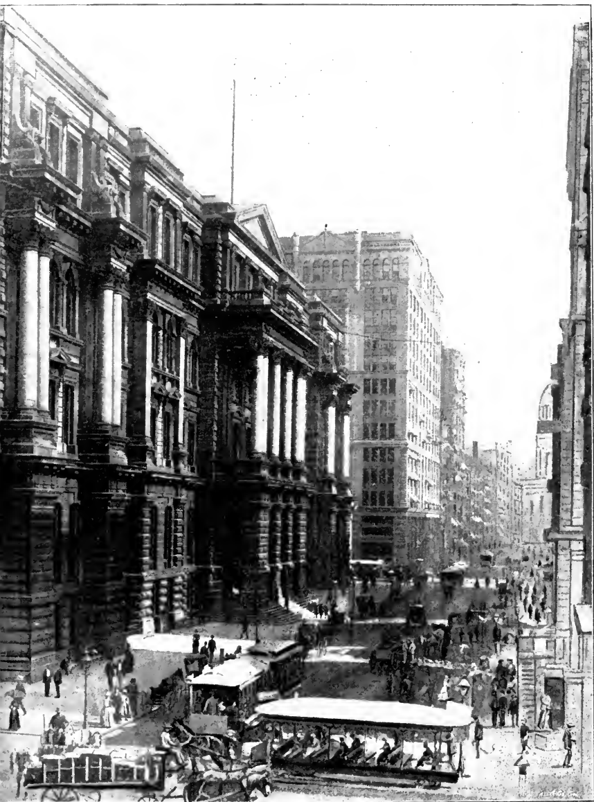
Ecke von Laſalle- und Randolph-ſtraße.
