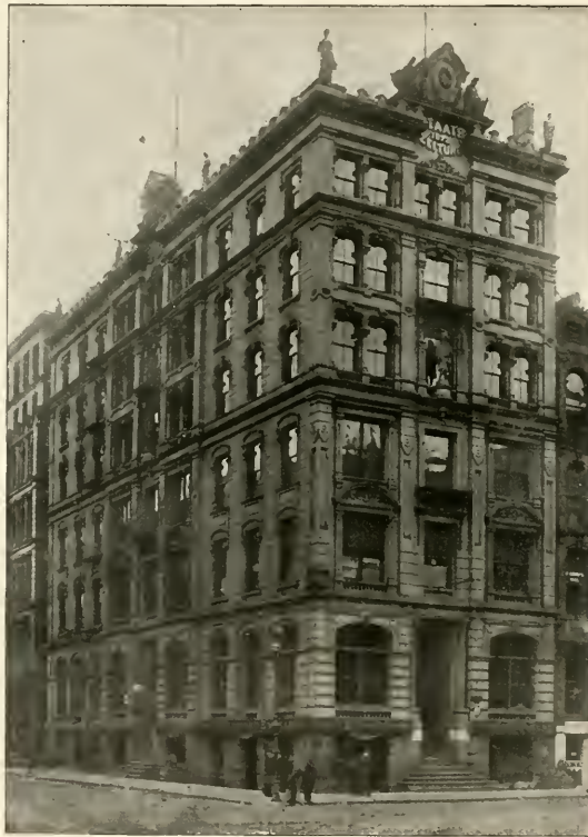
STAATS ZEITUNG BUILDING.
