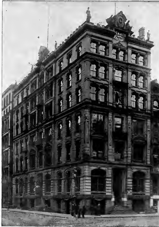
STAATS ZEITUNG BUILDING.
