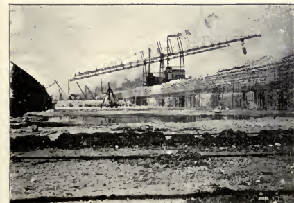
Der Abzugs-Kanal während der Bau-Periode.
