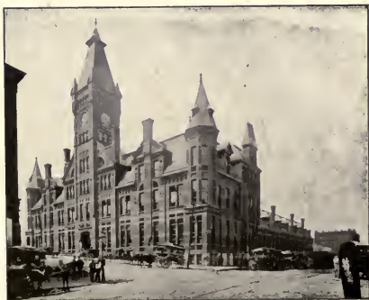
Chicago und North Western Depot.
