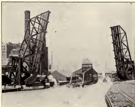
Scherzer Roller Klappbrücke.
