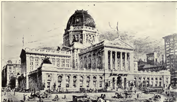
Das neue Post-Gebäude. Im Bau begriffen.
