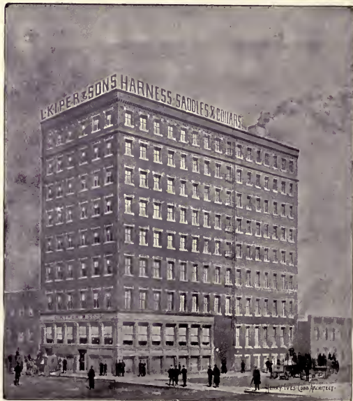
Fabrik-Gebäude der Herren Louis Riper und Söhne.
