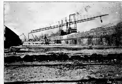
Der Abzugs-Kanal während der Bau-Periode.
