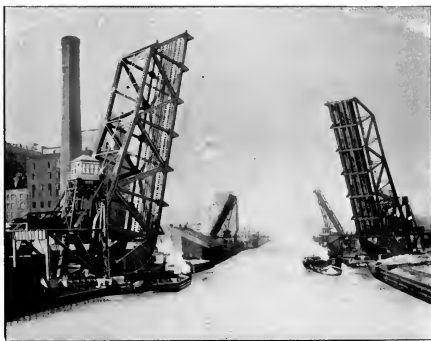
Scherzer Rollen-Klappbrücke und Ansicht der alten Drehbrücke.
