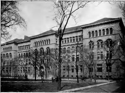
Newberry Bibliothek-Gebäude. Washington Square. — Nordseite.
