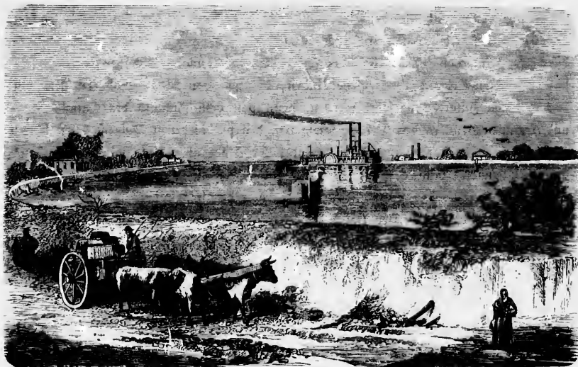
Uferdämme am unteren Mississippi.
