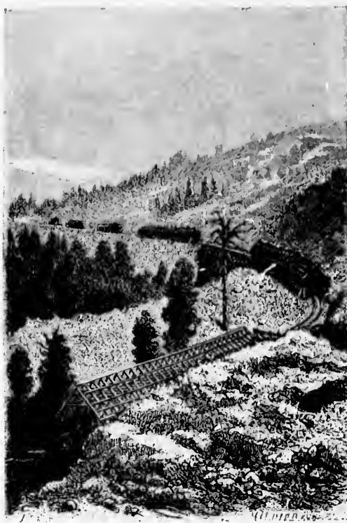
Die Pacific-Bahn: Schnee-Tunnels in den Felsengebirgen.
