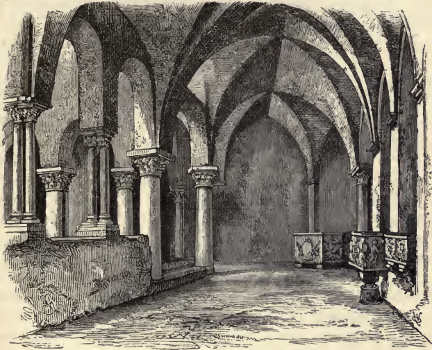
Cloister of S. Trinità, Cava.
