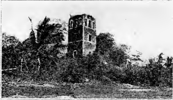
Ruinas de la Catedral en la antigua Panamá.
