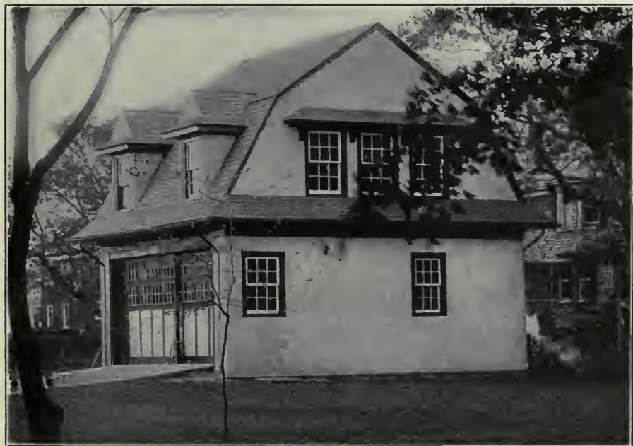
Stucco Garage, Far Rockaway, L. I.
